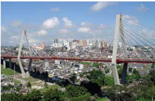
Figura 16. Área Metropolitana de Centro Occidente. Adaptado de: Velásquez. (2004). Viaducto Cesar Gaviria Trujillo
